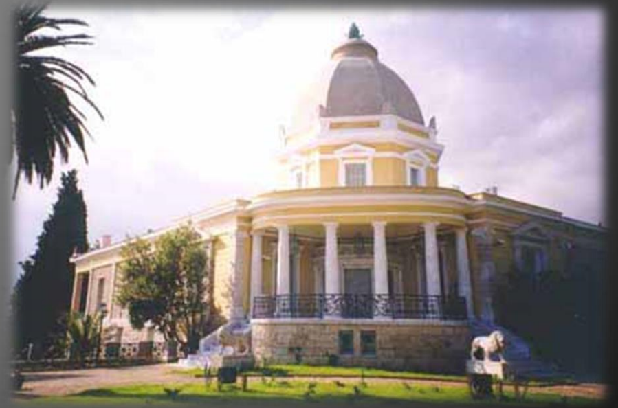
Βίλα Καζούλη, Κηφισιά
